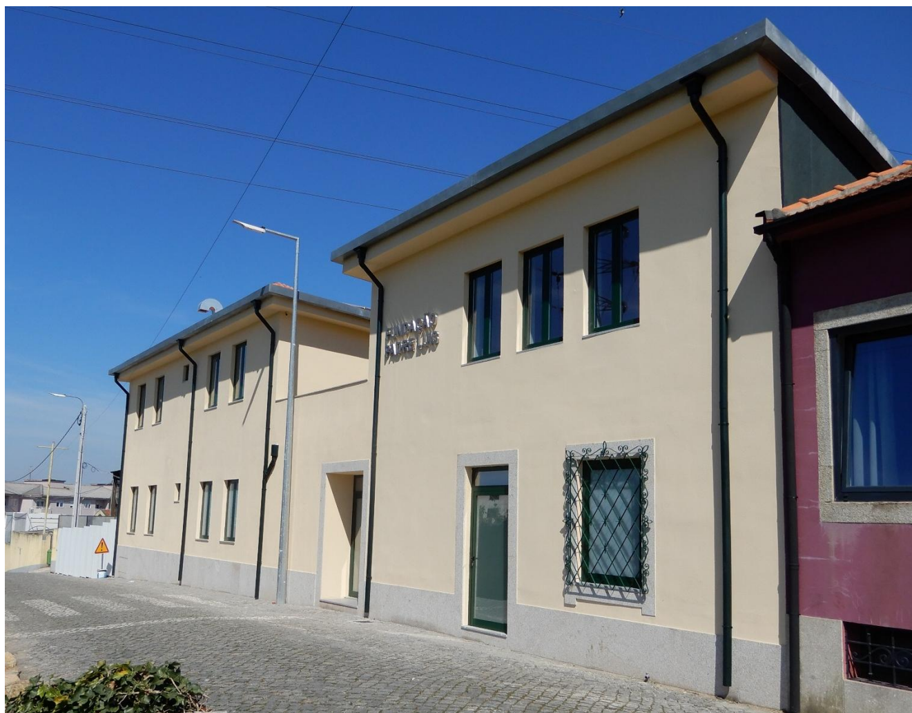
Figura 2 - Edifício principal - Serv.Adm - SAD - SAAS
