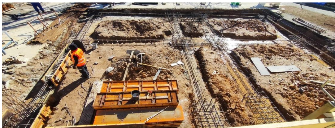
Figura 8 Piso térreo (onde vão nascer os pilares para as 2 salas)
