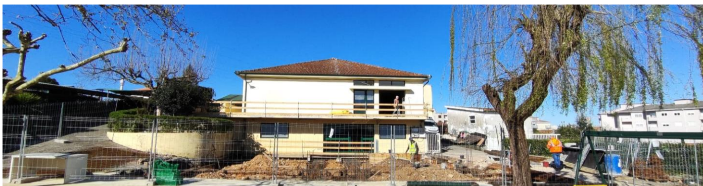
Figura 10 espaço da Ampliação salas atividades em Creche
